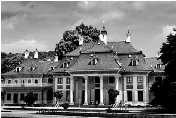
Монплезир в Петергофе (вверху) и Водный дворец в Пильнице близ Дрездена (внизу). Стилизация крыши в характере chinoiserie – в контаминации с мансардной кровлей.
