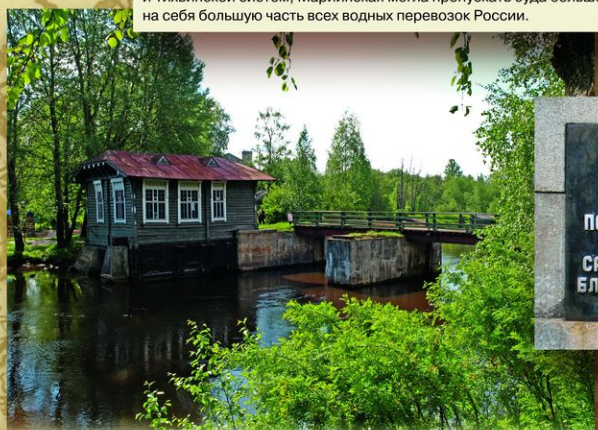
Вытегра, Вологодская область. Остатки шлюза Мариинской системы. Петр I посетил Вытегру в 1711 и в течение 10 дней осматривал древний волок между реками Вытегра и Ковжа. В 1715 здесь была устроена государственная верфь, а в конце XVIII века прошла Мариинская водная система. В здании у разрушенного шлюза сегодня располагается музей истории Волго-Балтийского канала.
