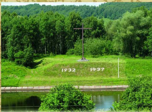
Дмитров. Канал имени Москвы. Петр I предполагал соединить Москву-реку с Волгой, чтобы усилить роль Москвы как торгово-промышленного центра. В 1721—1722 было разработано три маршрута, но к строительству не приступили. Идея Петра I была осуществлена в XX веке. Канал был открыт в 1937. При строительстве использовался труд заключённых Дмитровлага.
