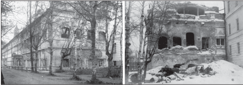
5. Царские Чертоги до разборки пристройки 1892 (слева). Фото 1927. После разборки пристройки 1892 (справа). Фото 1928. Публикуется впервые. Архив СПМЗ
