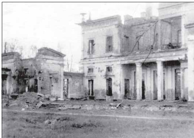
11. Разрушенный дворец. Фото 1943 г.
