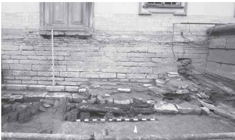
6. Свайное основание с деревянными плахами и полуразобранная каменная кладка крыльца перед входом во дворец
