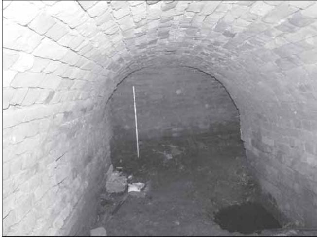
7. Внутренне пространство коллектора. Продольный канал
