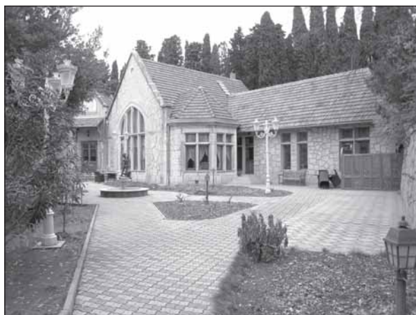
Дворик-патио после реконструкции. Объём со шипцом – новодел. Фото С.С. Левашко, 2014 г.
