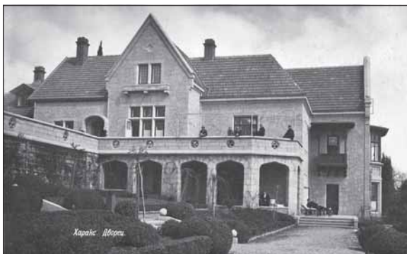
Западный фасад. Фотооткрытка. РНБ, отдел эстампов
