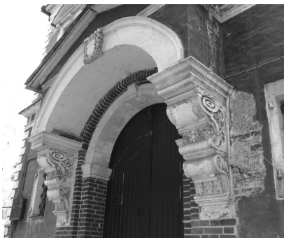
7. Палаты А. Кириллова— А. Курбатова на Берсеневской набережной. Каменный зонт над главным входом центрального ризалита. Фото 2010-х годов.
