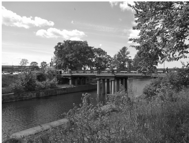
Шлиссельбург. Мост на гранитных колоннах в историческом центре города.
