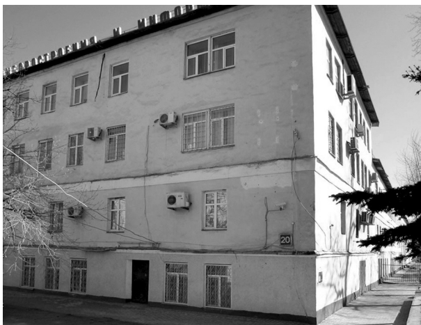
8. Московская парусная (адмиралтейская) фабрика на Язуе. Западный корпус. Фото 2010-х годов.
