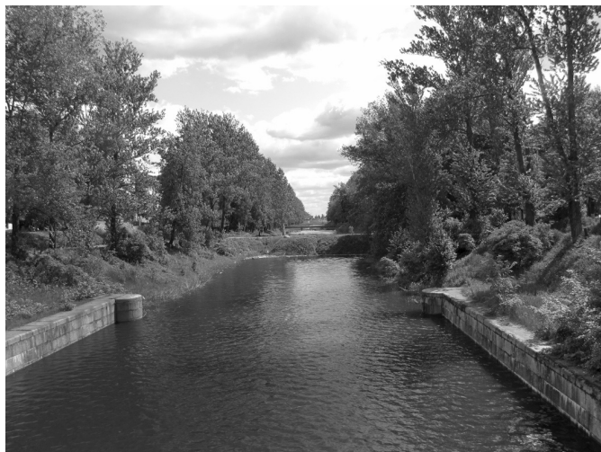
Шлиссельбург. Перемычка на Староладожском канале в центре города. Фото из Музея истории города Шлиссельбурга.
