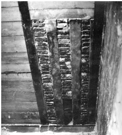
3. Фрагмент первоначального балочного перекрытия в северо-восточном углу Большой палаты. Фото 1970-х годов.
