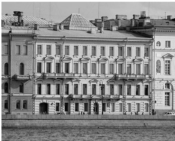
Дом корабельного мастера Федосея Скляева (Дворцовая наб., 30). 1720-е годы. Современное состояние. Кирпичная кладка петровского времени сохранилась на всю высоту двух нижних этажей (верхние надстроены в XIX веке).
