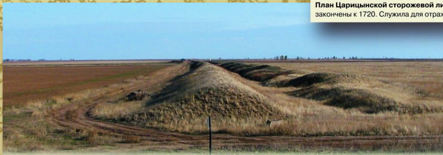
Царицынская сторожевая линия (Петровский вал). Современный вид. Царицынская линия представляла собою земляной вал длиной в 60 км и высотой до 12 м и включала 4 земляные крепости. Считалась одним из крупнейших фортификационных сооружений Европы.
